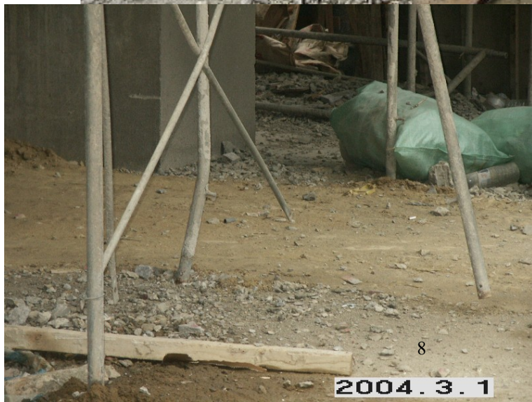
照片 5-2. 基礎地面應平整、夯實緊密、襯以適當材質之墊材，施工架底部之立架設可調型基腳座鈑，以避免產生不均勻沉陷。
