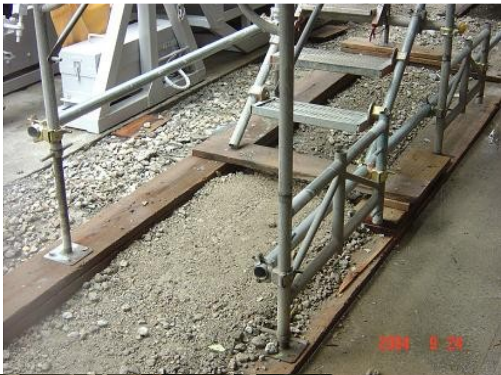
照片 5-2. 基礎地面應平整、夯實緊密、襯以適當材質之墊材，施工架底部之立架設可調型基腳座鈑，以避免產生不均勻沉陷。
