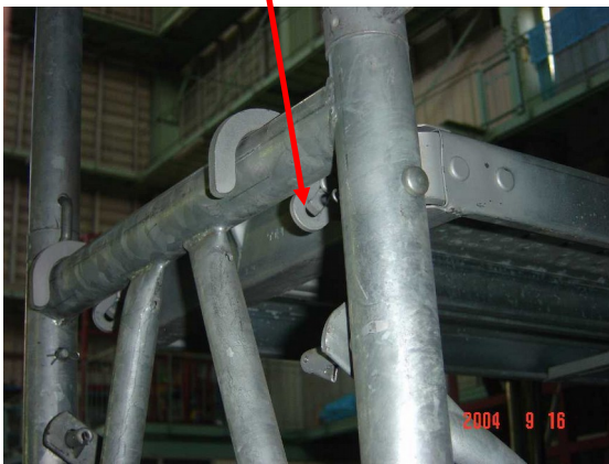
照片 4. 板料設防脫落鉤固定以避免翻覆。
