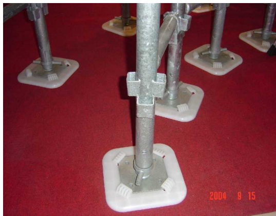
照片 5-1. 施工架腳部設置基座增加穩定性。
