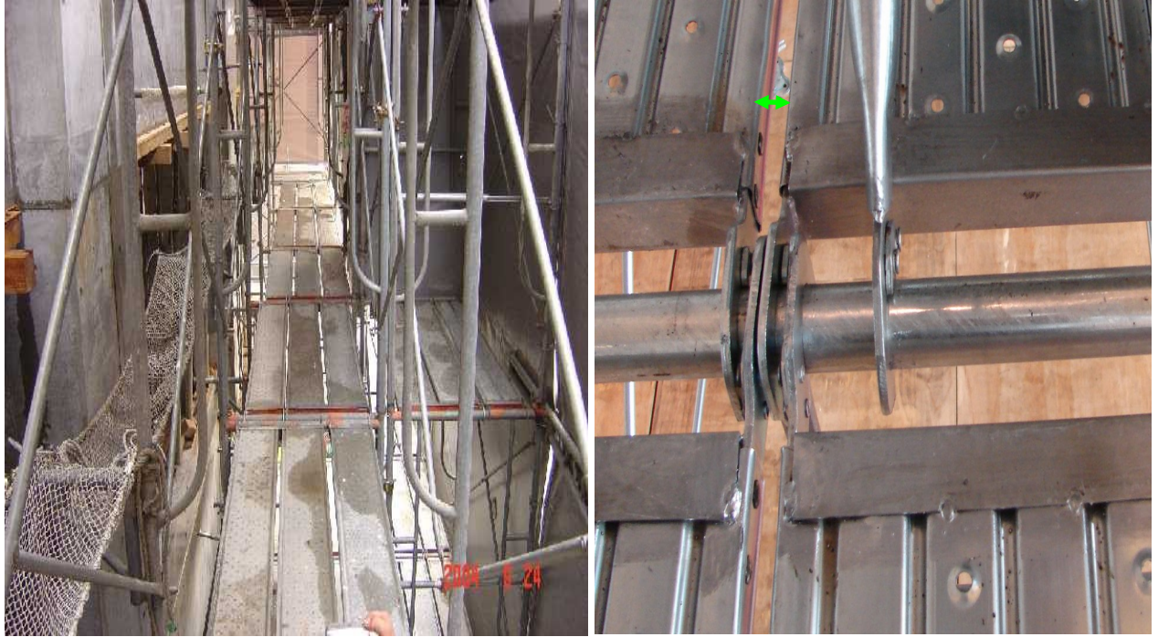
照片 3-1. 施工架板料、板料間之縫隙不得大於 3 公分。
